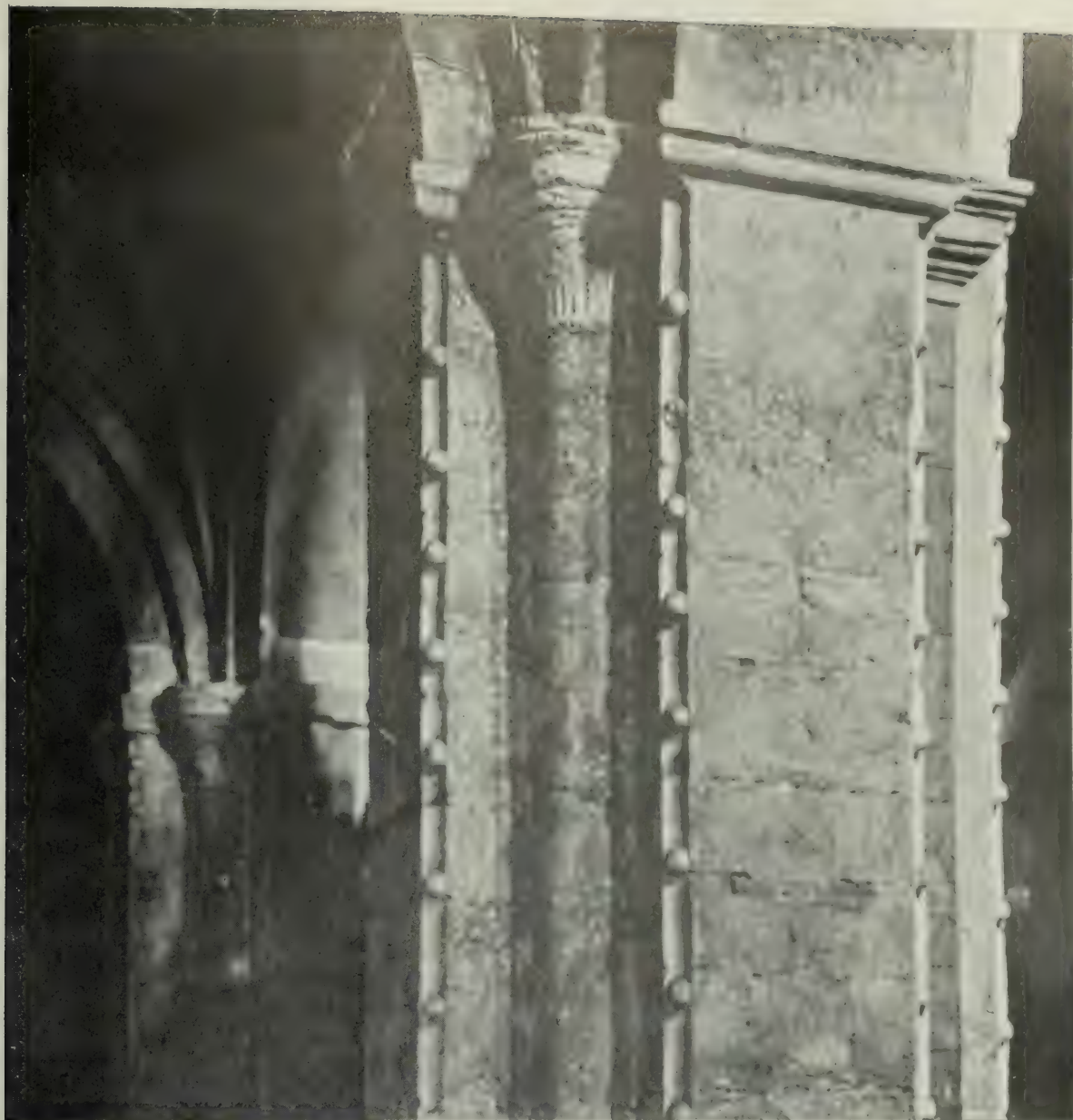
Fig. XIII. — Pilars del temple després de restaurats. (Fot. A. Oromi)
